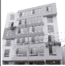
Residencial Torre Tagle PUEBLO LIBRE FEBRERO 2011
