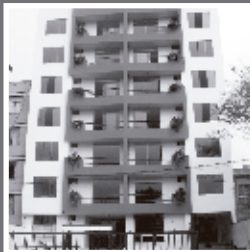
Edificio Parque Echenique PUEBLO LIBRE JULIO 2009
