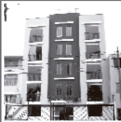
Edificio Río Grande PUEBLO LIBRE MAYO 2010
