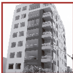
Edificio Del Parque PUEBLO LIBRE DICIEMBRE 2012
