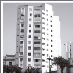
Edificio Los Libertadores MAGDALENA DEL MAR DICIEMBRE 2008
