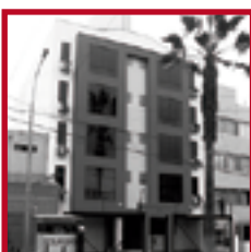
Edificio Parque Grau PUEBLO LIBRE JULIO 2007
