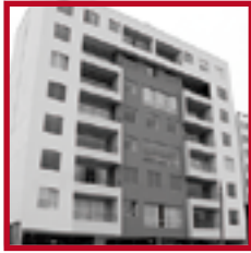
Edificio Los Tulipanes MAGDALENA DEL MAR OCTUBRE 2012
