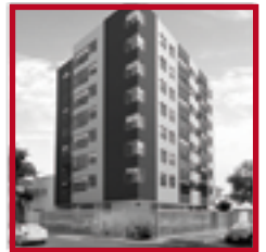
Edificio Rivadavia II PUEBLO LIBRE ENERO 2018
