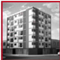
Edificio Camino del Parque PUEBLO LIBRE ABRIL 2016
