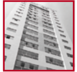
Edificio El Libertador PUEBLO LIBRE FEBRERO 2012
