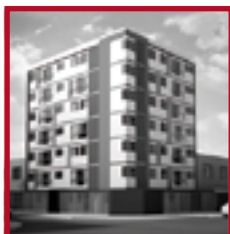
Edificio Camino del Parque PUEBLO LIBRE ABRIL 2016
