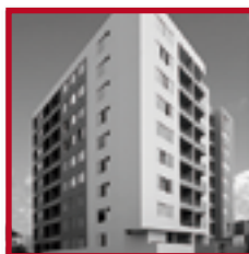
Edificio Bali PUEBLO LIBRE MAYO 2014
