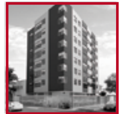
Edificio Rivadavia II PUEBLO LIBRE ENERO 2018
