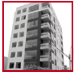
Edificio Del Parque PUEBLO LIBRE DICIEMBRE 2012
